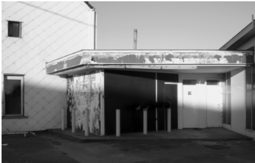
AutotimerAutoshot: gasstation roof
